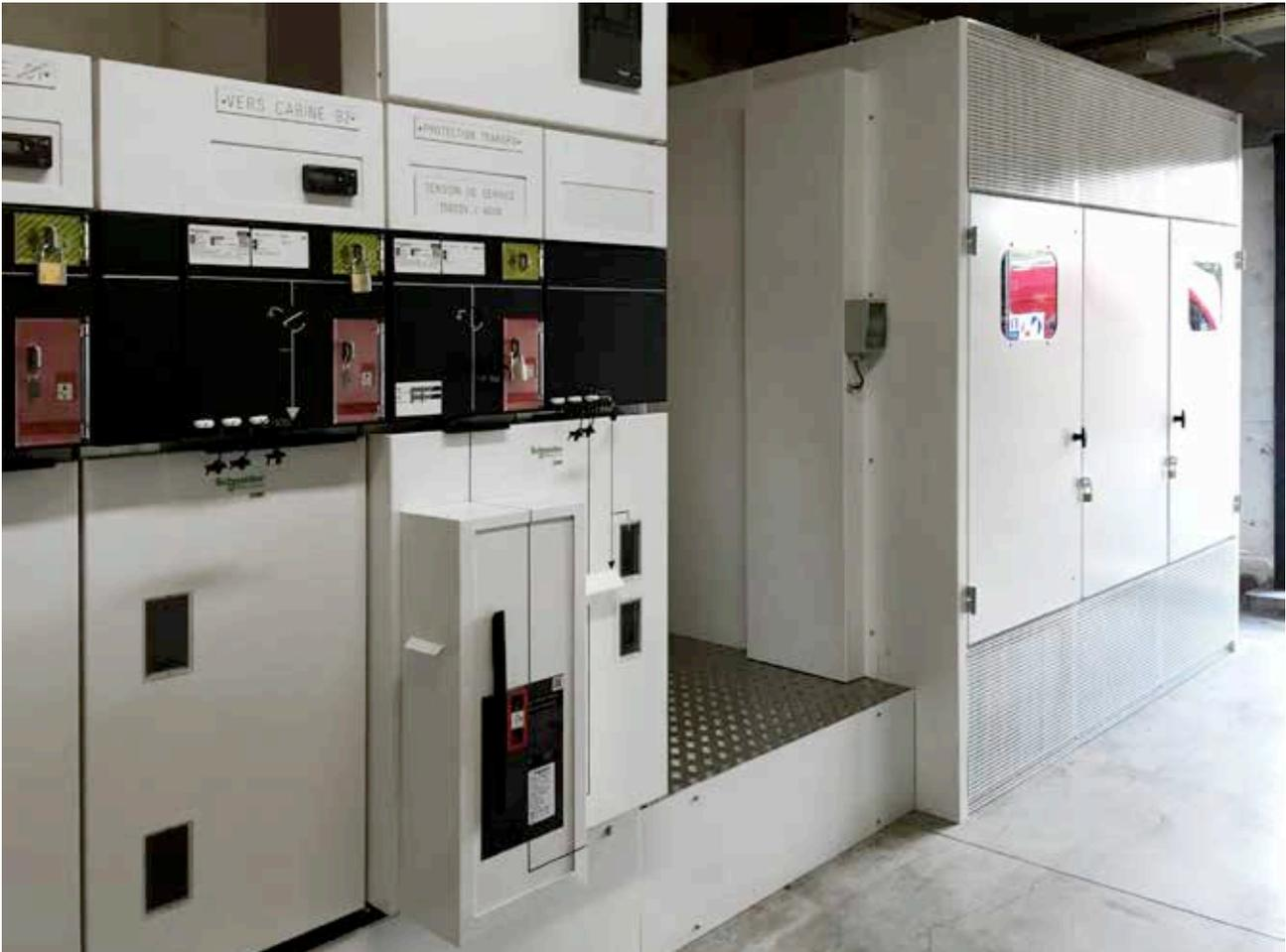
**RÉALISATION** Cabine MT pour les bâtiments, travaux de remplacement de cabines MT existante avec un timing réduit au maximum. Bâtiment B4:1x1600Kva +TGBT 2500A, Bâtiment S5 :1x1000Kva+TGBT1600A+Batterie condensateur, Bâtiment B2:2x1600Kva+TGBT 5000A+Batterie condensateur, Bâtiment B1: 1x2000Kva + redresseur 110v, Bâtiment S2 : 1x400Kva+redresseur 110v. Composants, TGBT Schneider (Prisma), disjoncteurs (Schneider), cabine MT type modulaire Schneider.
