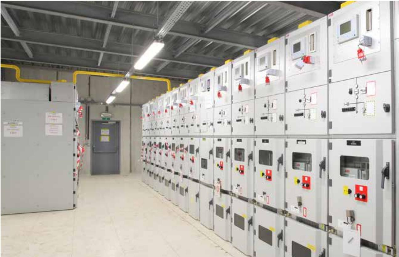
**RÉALISATION** Contrat de fourniture armoires pour poste HT/MT, Armoires service auxiliaire, Armoire frontière, composants, armoire (Eldon), disjoncteurs (Schneider).
