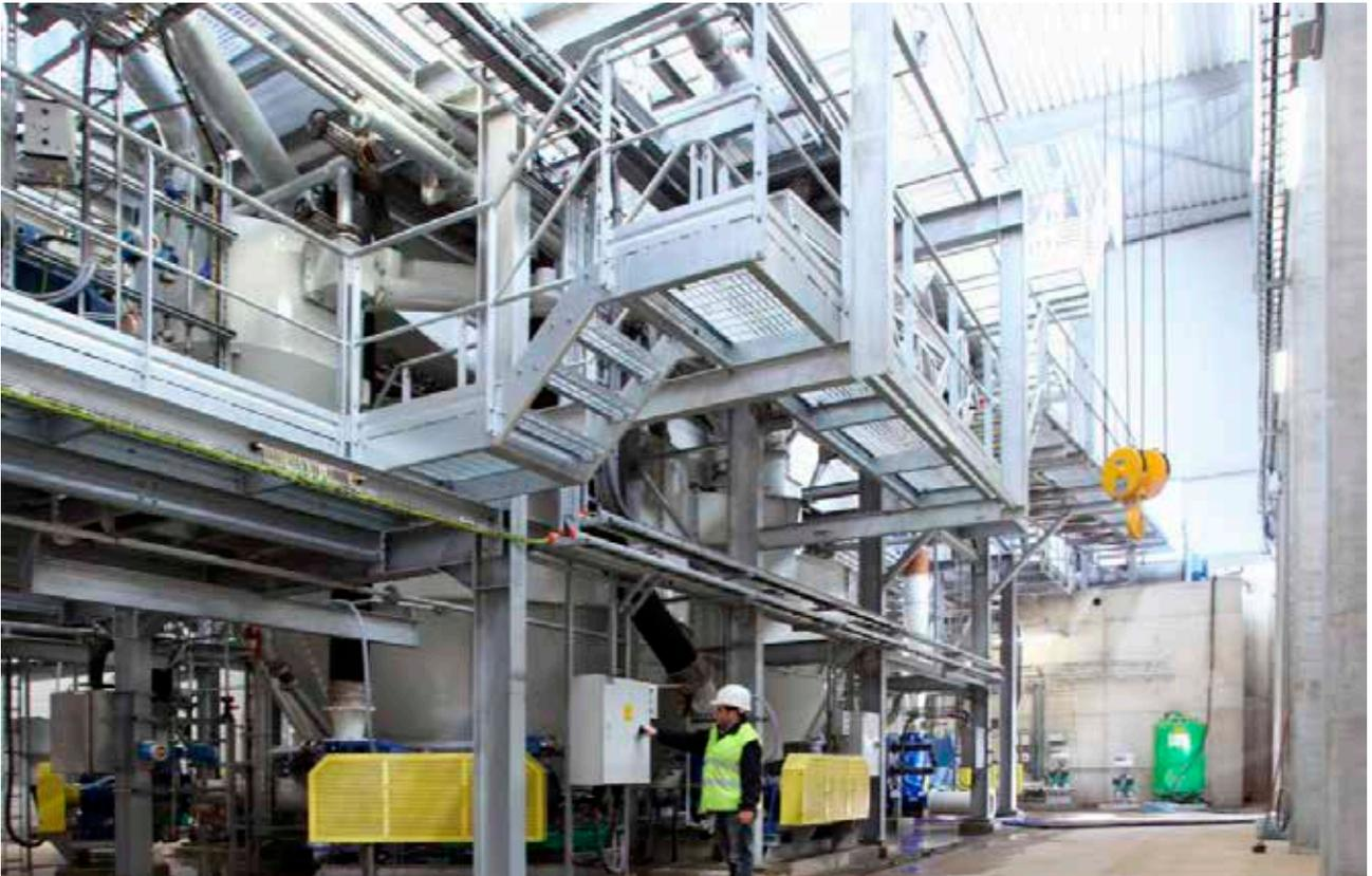
**RÉALISATION** Installation électrique de déshydratation des boues, fabrication et montage tableaux, livraison tableaux d'éclairage EEx et non EEx et installation d'éclairage, tracing, câblage data, tubes et chemins de câbles, instrumentation EEx et non EEx, assistance et mise en service.
